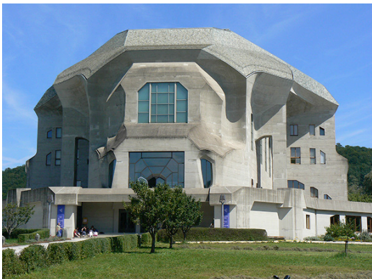
Goetheanum, vue d'ensemble, face ouest
